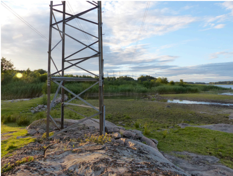
Boxplats vid Östra Hästefjorden, Gunnarsberg (titta i högra delen av kraftledningsstolpen).
